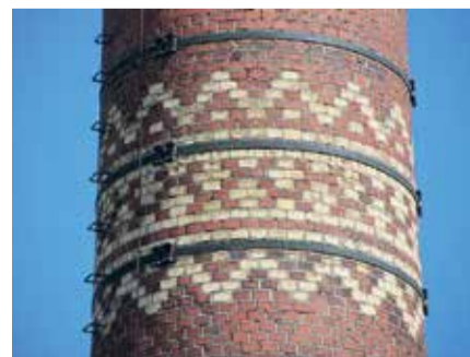
Detail van versierend metselwerk in de fabrieksschoorsteen 'Vier Noorder Koggen'.
