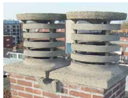
Karakteristieke schoorsteenkoppen van het type Shunt.
