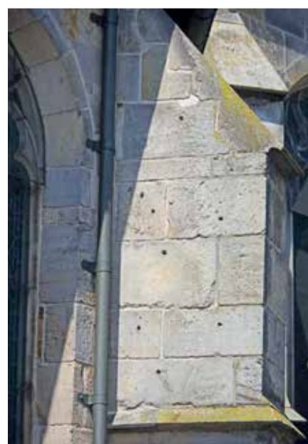
Voorbeeld van natuurstenen blokken met putjes voor het hijsen met een steenschaar. Foto: K. Boeder
