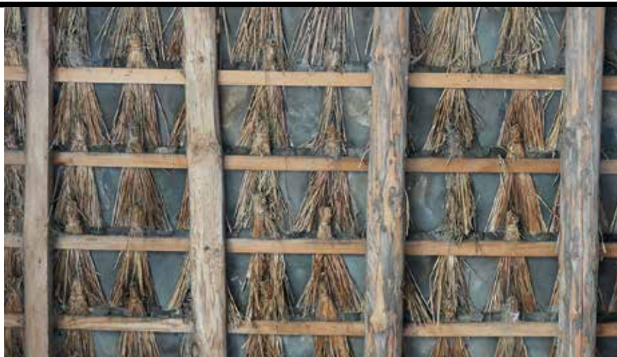
Een pannendak dat wind- en sneeuwdicht gemaakt is met behulp van strodokken.
