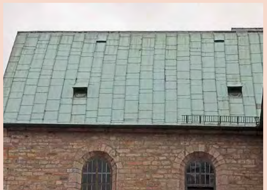
De Dom van Hildesheim (Duitsland) waarvan het dak bekleed is met een gefelste koperbekleding met karakteristieke dwarsfelsen. Foto: K. Boeder.
