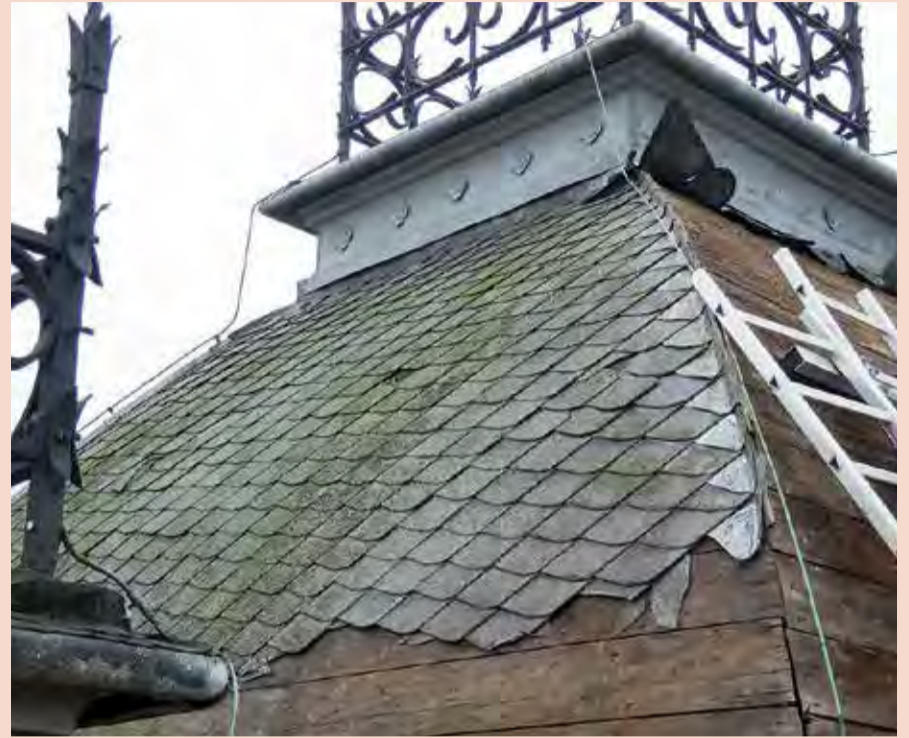
Een Sjabloondekking met veel te sterke stijglijn. Foto: W.G. van Reenen
