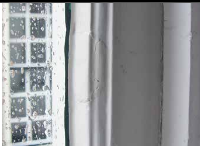
Een voorbeeld van een litteken van een weggezaagde roede. Het glas in dit raam komt dus niet uit dezelfde bouwphase als het raam. Afbeelding: W.G. van Reenen.
