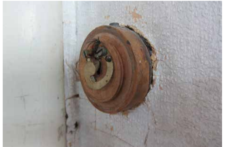
Dezelfde drukknop als de linker afbeelding, maar waarbij de houten behuizing is losgedraaid en de verende plaatjes zichtbaar zijn die een gesloten stroomkring maken wanneer op de knop gedrukt wordt.
