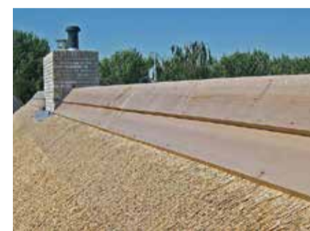
Nokafwerking van houten planken. Foto: K. Boeder
